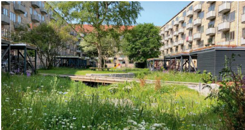
Regnvandshåndtering i gård, Fremtidens Gårdhaver, Aksøgade
