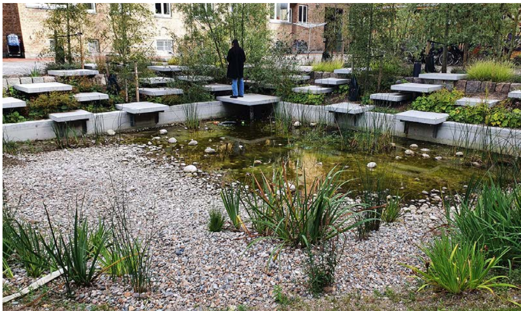
Regnvandshåndtering i boligkarré, Straussvej , København
