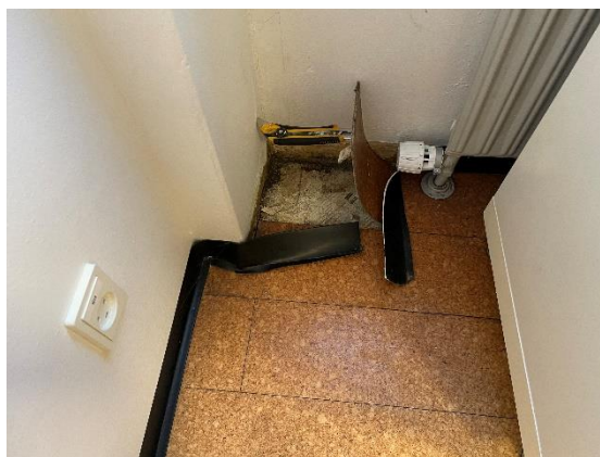
Billede 1. Visuelle tegn på vandindtrængning fra vindue i facaden (røde pile). Billede 2. Løs gulvbelægning. P5 er udtaget her.
