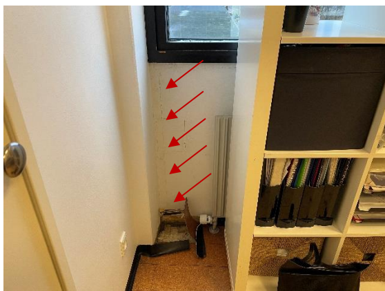
Billede 1. Visuelle tegn på vandindtrængning fra vindue i facaden (røde pile). Billede 2. Løs gulvbelægning. P5 er udtaget her.
